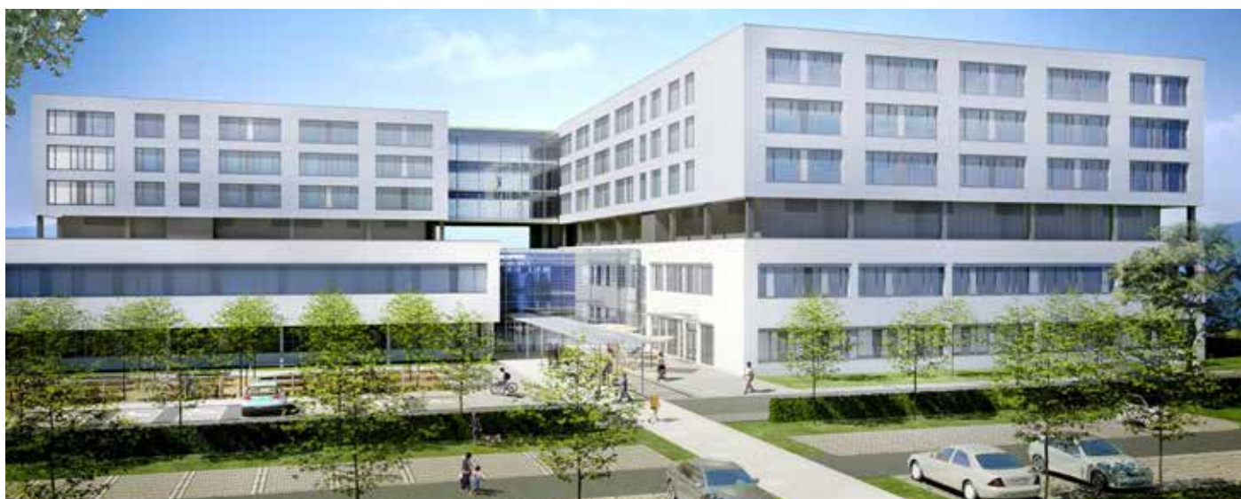
Neubau Klinikum am Plattenwald, Bad Friedrichshall
