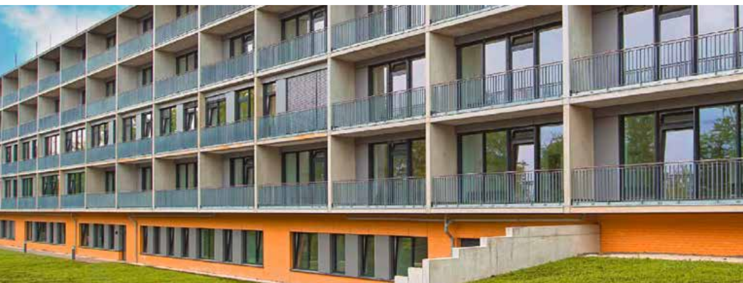
Klinikum Heidenheim – Neubau Haus C
