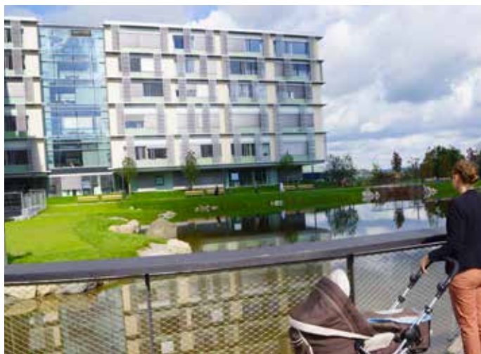
In Ravensburg ist der 1. Bauabschnitt der Erneuerung des Krankenhauses St. Elisabeth abgeschlossen.
