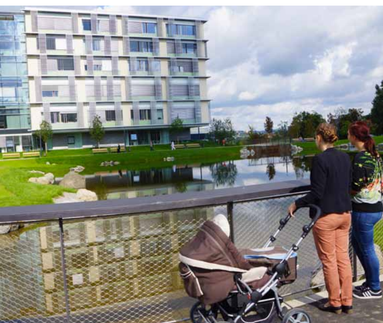
In Ravensburg ist der 1. Bauabschnitt der Erneuerung des Krankenhauses St. Elisabeth abgeschlossen.
