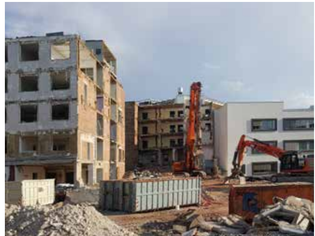
Der Abriss der alten HNO-Klinik.
